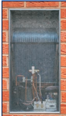
Climatizzatore ad incasso / In-wall air conditioner
